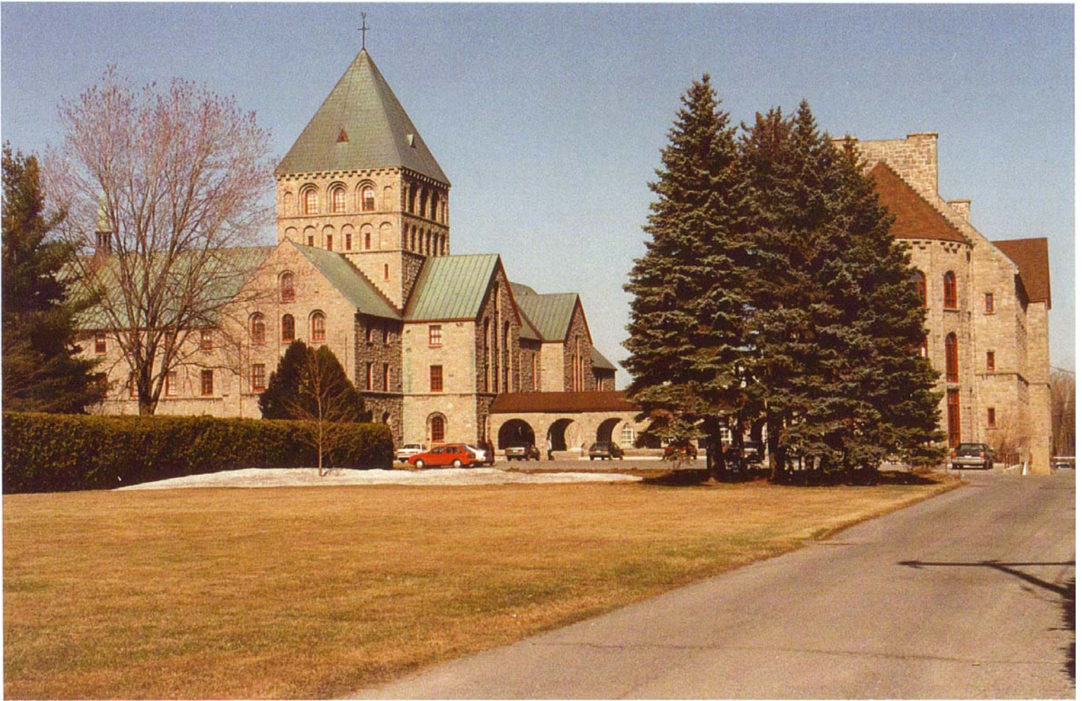
Le Noviciat de Joliette, oeuvre maîtresse du père Wilfrid Corbeil, architecte. (Photo, R. Foisy). L'architecture de pierre se profile dans des jeux d'ombre qui se déplacent au rythme du soleil, et permet d'admirer sous des angles différents l'équilibre géométrique du monument. Du soleil levant au soleil couchant, on se laisse surprendre par la mesure divine du compas de proportion de l'architecte.
